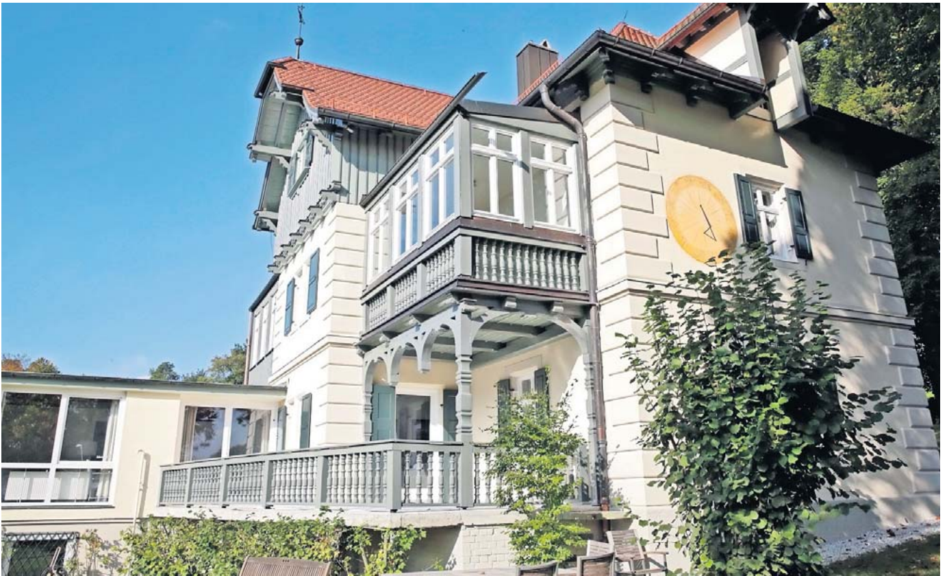
Ein schmales Gebäude ist die Villa an der Seeuferstraße nach der umfangreichen Sanierung wieder geworden. An der Rückseite wurde in den 60-er Jahren ein modernerer Gebäudekomplex angefügt. FOTO: HARTMUT PÖSTGES
