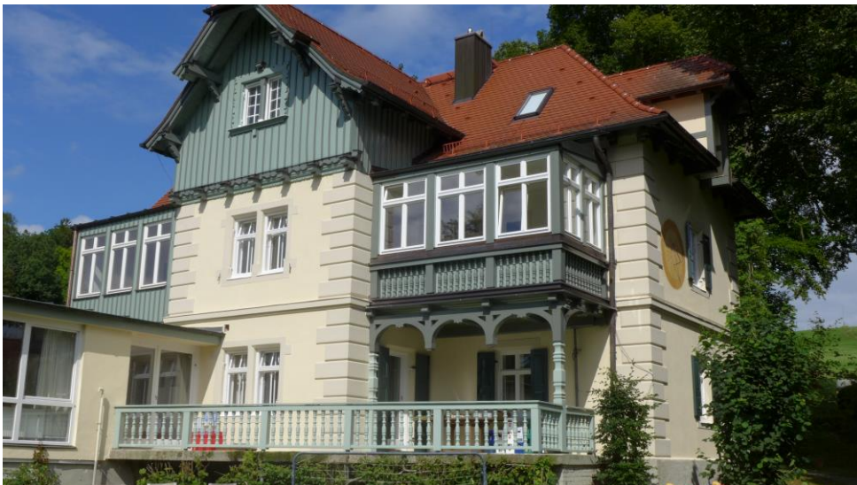
Ansicht Villa von Waldemar Bonsels Villa von Süd-Westen nach Fassadensanierung
